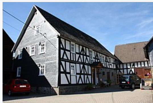
Wohnhaus in Elsoff
